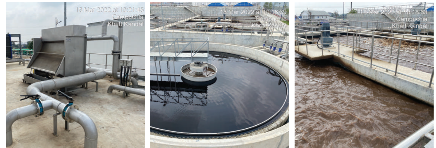
▶ Cung cấp & Lắp đặt hệ thống điều khiển tự động hoá cho Trạm xử lý nước thải Nhà máy Bia Human
