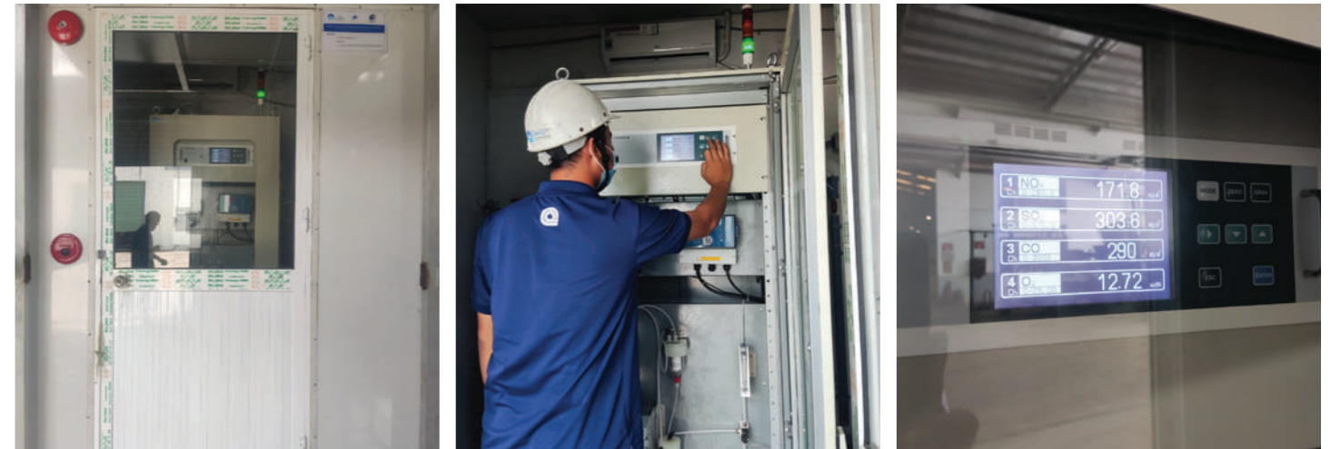
Cung cấp & Lắp đặt hệ thống quan trắc khí thải tự động tại Nhà máy Young IL Việt Nam
