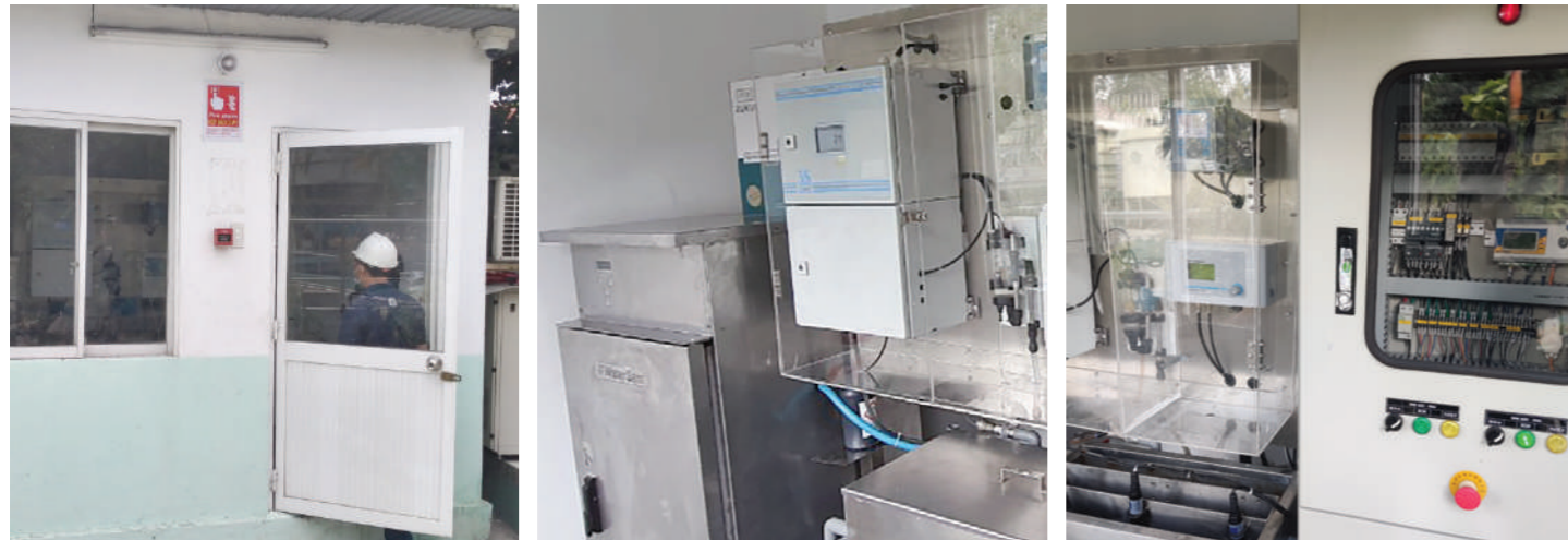
| Cung cấp & Lắp đặt hệ thống quan trắc nước thải tự động tại Nhà máy Chyang Sheng Việt Nam
